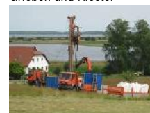
Brunnensbau auf der Urlaubsinsel
