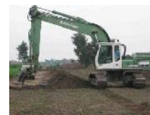
Mutterbodenabtrag
