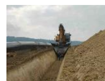
Rohrgrabenaushub
