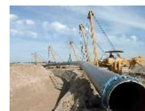
Absenken Rohrstrang
