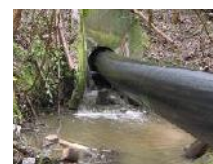
Rohreinzug am Auslauf
