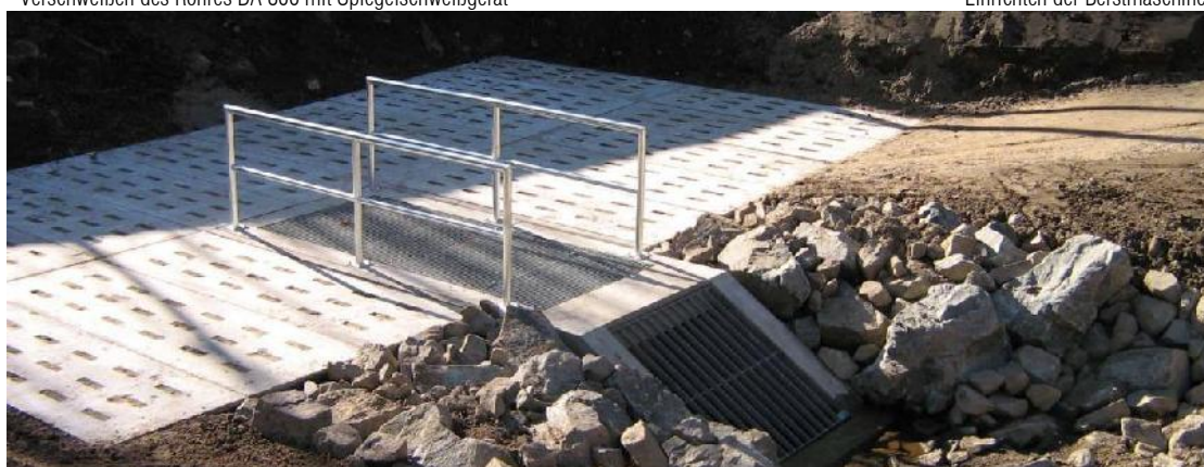
Einlaufbauwerk zur Rohrleitung
