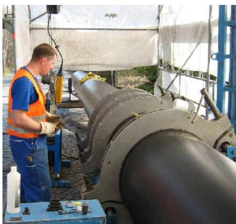
Verschweißen des Rohres DA 800 mit Spiegelschweißgerät
