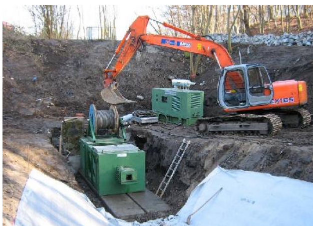
Einrichten der Berstmaschine
