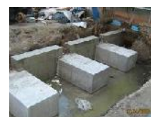
Fundamente und Zwischenwände
