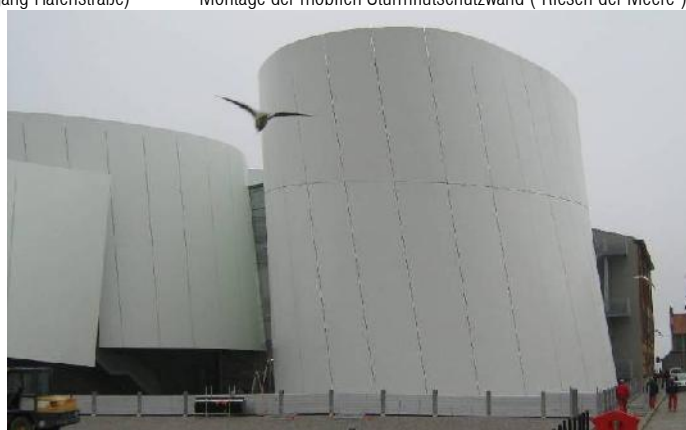
Mobile Sturmflutschutzwand ("Riesen der Meere")
