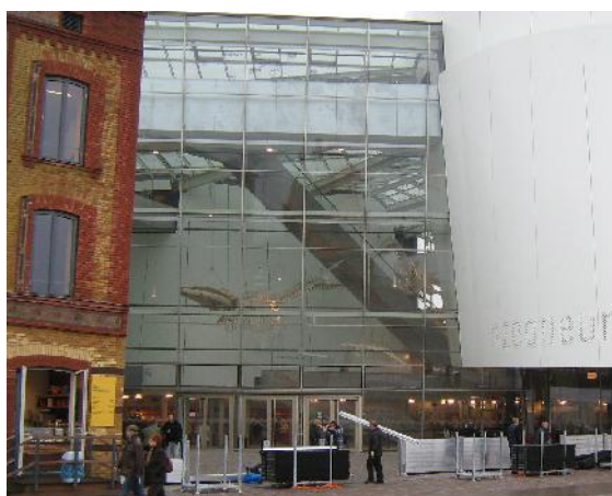
Mobile Sturmflutschutzwand (Haupteingang Hafenstraße)
