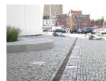
Ankerplatten im Pflaster
