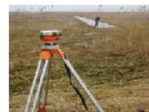
Überprüfung der Höhenverhältnisse im Polder
