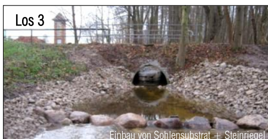
Einbau von Sohlensubstrat + Steinriegel
