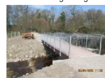
Errichtung einer Fußgängerbrücke über die FAA
