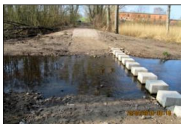
Umbau zur Furt mit Trittsteinen
