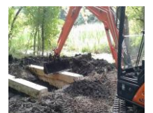
Grabenverbau (Holzspundwand)
