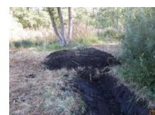
Grabenverfüllung (Torf)
