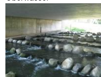
Vorhandene Sohlschwelle unter der Brücke
