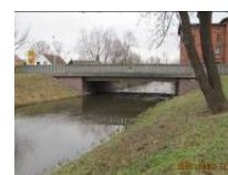
Vorhandene Brücke von Oberwasser
