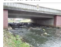
Vorhandene Sohlschwelle von Unterwasser
