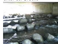
Vorhandene Sohlschwelle unter der Brücke
