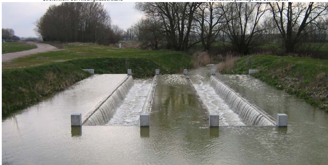
Streichwehr in Betrieb
