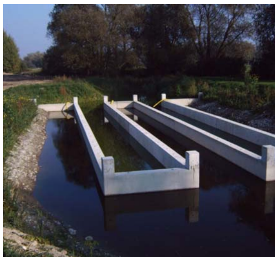
Streichwehr bei Niedrigwasserstand
