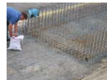
Bewehrung Bodenplatte
