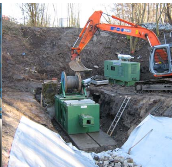
Einrichten der Berstmaschine
