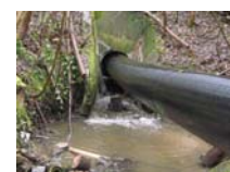
Rohreinzug am Auslauf
