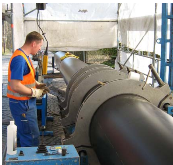
Verschweißen des Rohres DA 800 mit Spiegelschweißgerät
