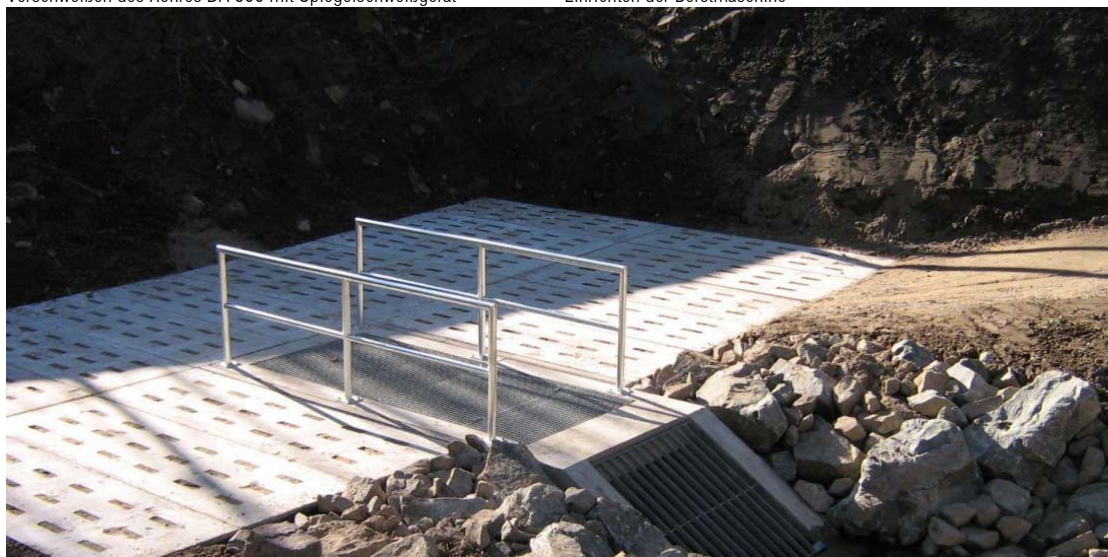
Einlaufbauwerk zur Rohrleitung
