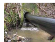
Rohreinzug am Auslauf
