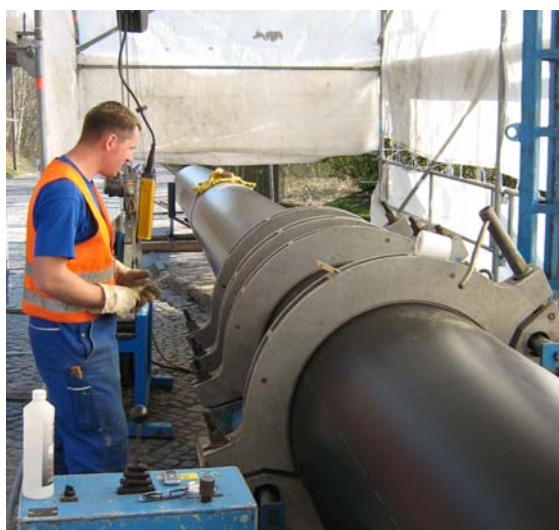
Verschweißen des Rohres DA 800 mit Spiegelschweißgerät
