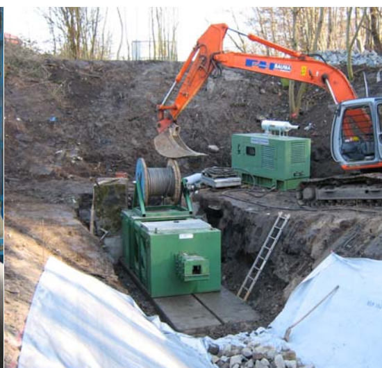
Einrichten der Berstmaschine
